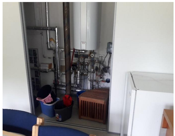
Bag skydelågerne: Støvsuger, gulvmoppe/spand.
